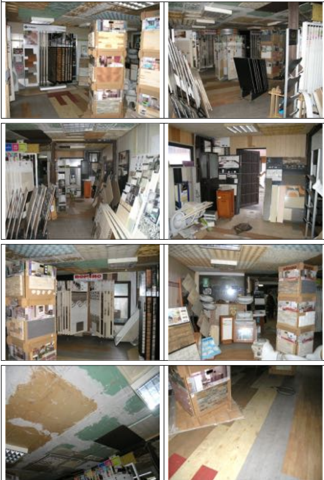
Stan wykończenia budynku – wnetrze (obiekt 1 → sala sprzedaży)
